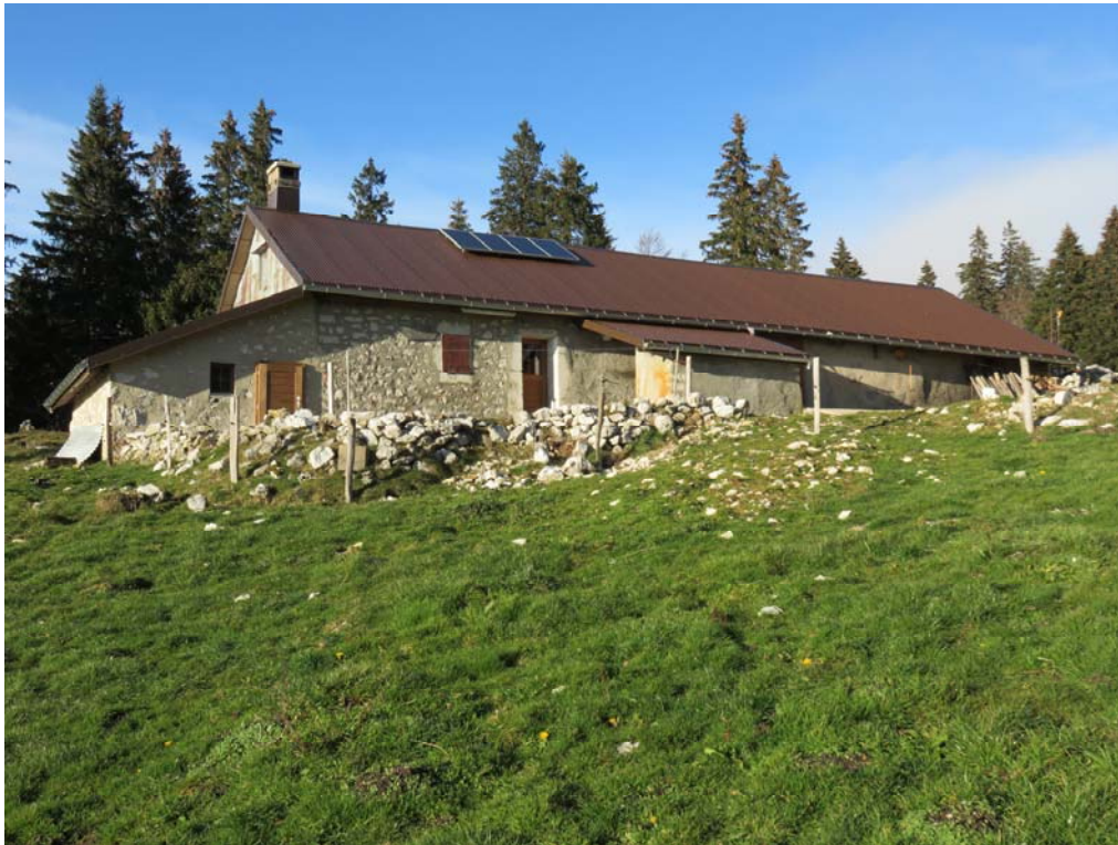
Chalet de la Petite-Dent dessus, propriété, tout comme le précédent, du village du Pont. Le toit vient d'être refait, présence de panneaux solaires.
